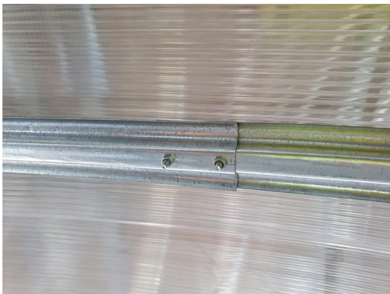
pohled z vnitřní strany skleníku na detail 1
